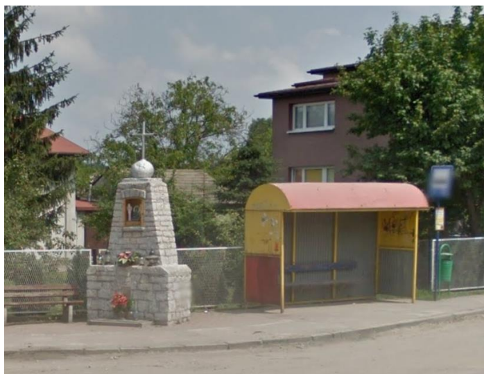
* Wiata przystanek Antoniów autostrada
